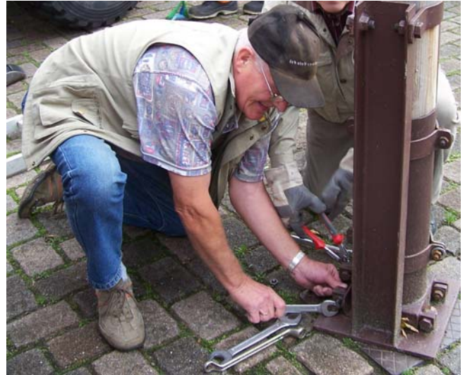
Herbert montiert die Halterung des Mai-Baumfußes
